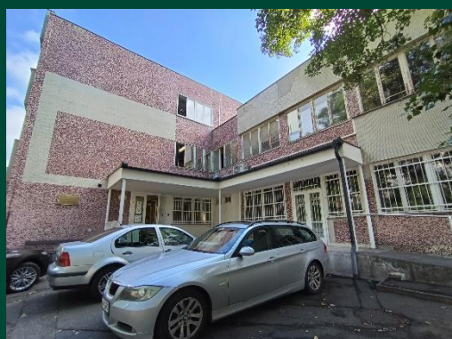
Pszichológiai Intézet épülete a felújítás előtt.
